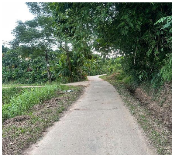
Hiện trạng đường BT 2,5m
